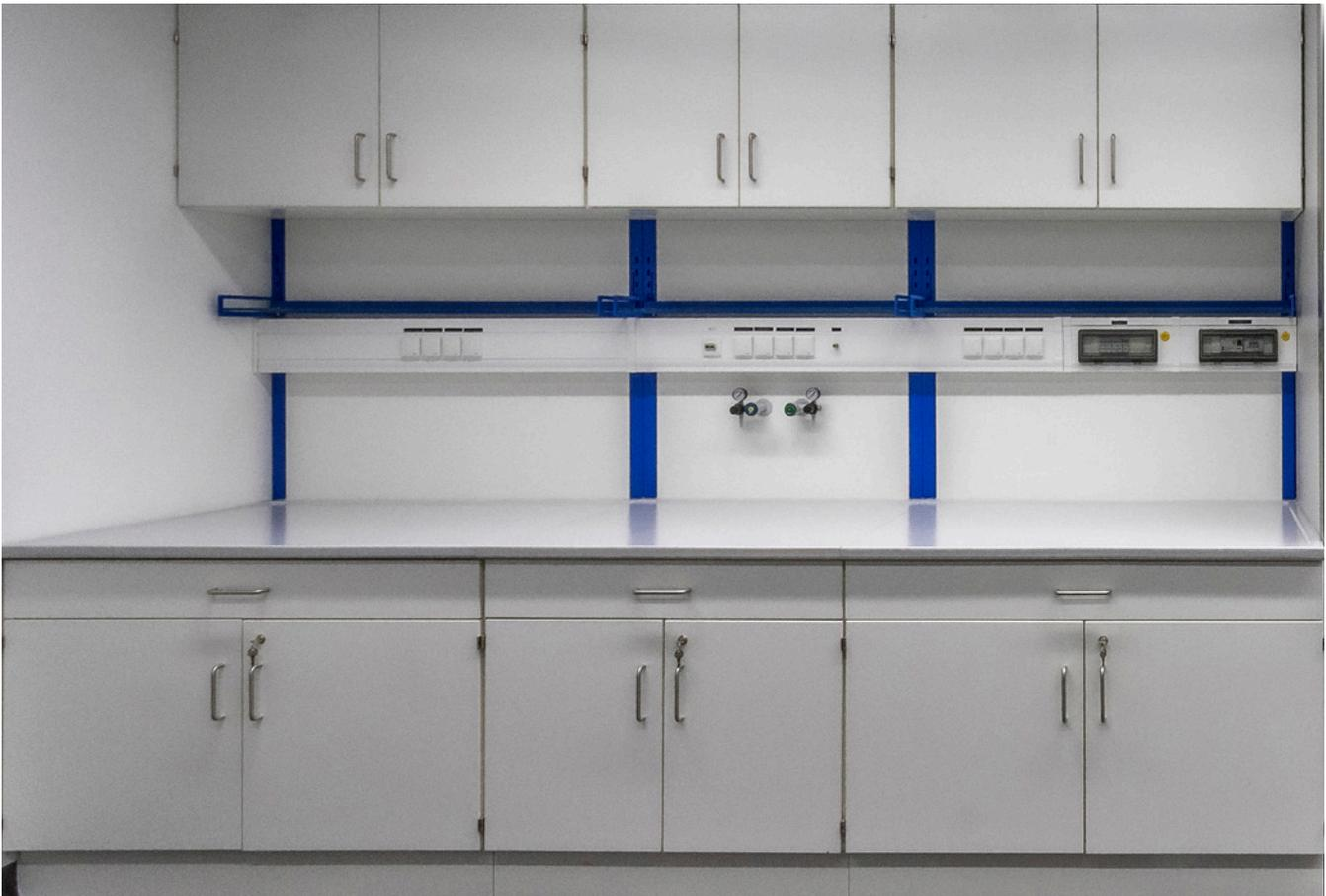
Unsere Medienzelle vereint alle wichtigen Anschlüsse – Strom, Gas, Wasser und Daten – in einer kompakten Einheit. Sie sorgt so für eine effiziente und sichere Laborversorgung. Das platzsparende Design eignet sich ideal für Labore mit begrenztem Raumangebot.
